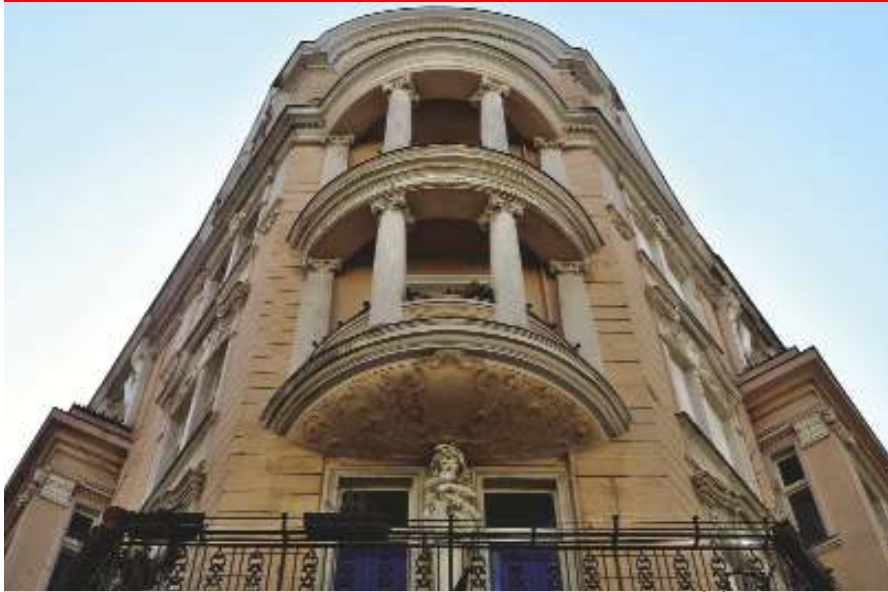
Das ist doch ... den sich in der Guster-Freytag-Str. 3. ... das Grundriss - Eckhaus Guster-Freytag-Str. 3 / Gutzkowstraße 5 in Schöneberg. Einer von drei Zugängen befindet sich in der Gutzkowstraße (KUNSTKELLER BERLIN), Aufgang I und Aufgang II zum Haus befinden sich in der Gutzkowstraße 3.
