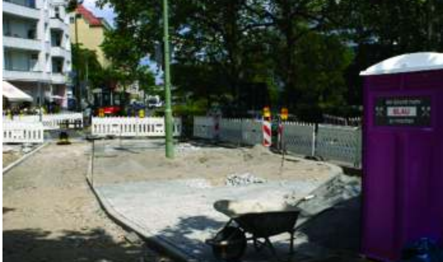
Die heißbegehrte Gehwegvorstreckung zum Bundesplatz in Arbeit
