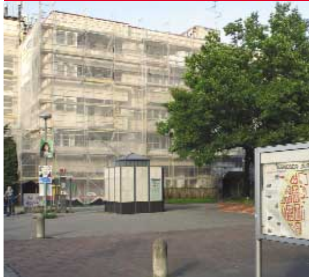
Eingerüstet - das „Haus am Dürerplatz“
