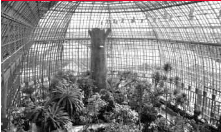
Blick vom Dach ins Tropenhaus. In der Mitte einer von zwei hochmodernen Klimatürmen
