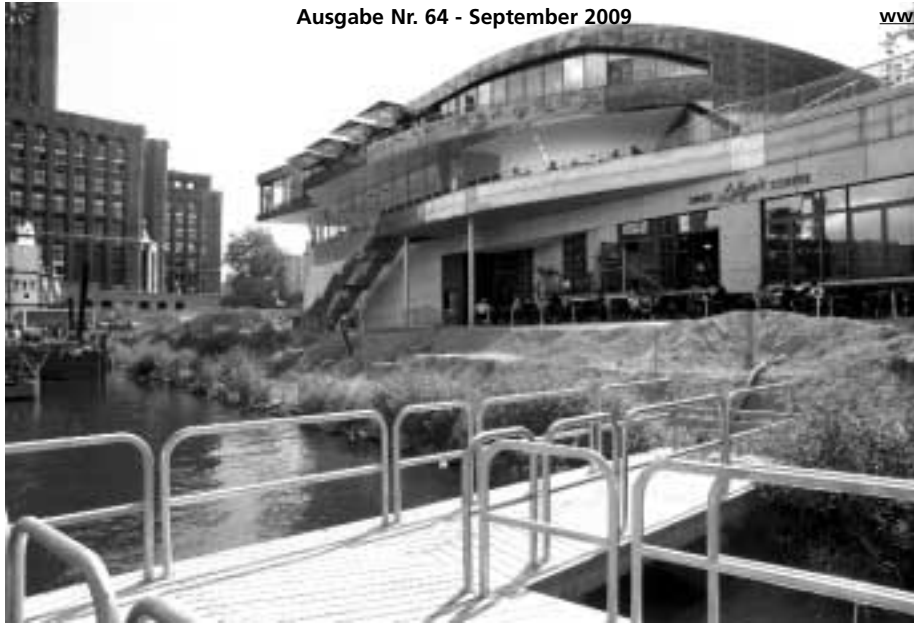
Noch eine große Baustelle. Der Tempelhofer Hafen
