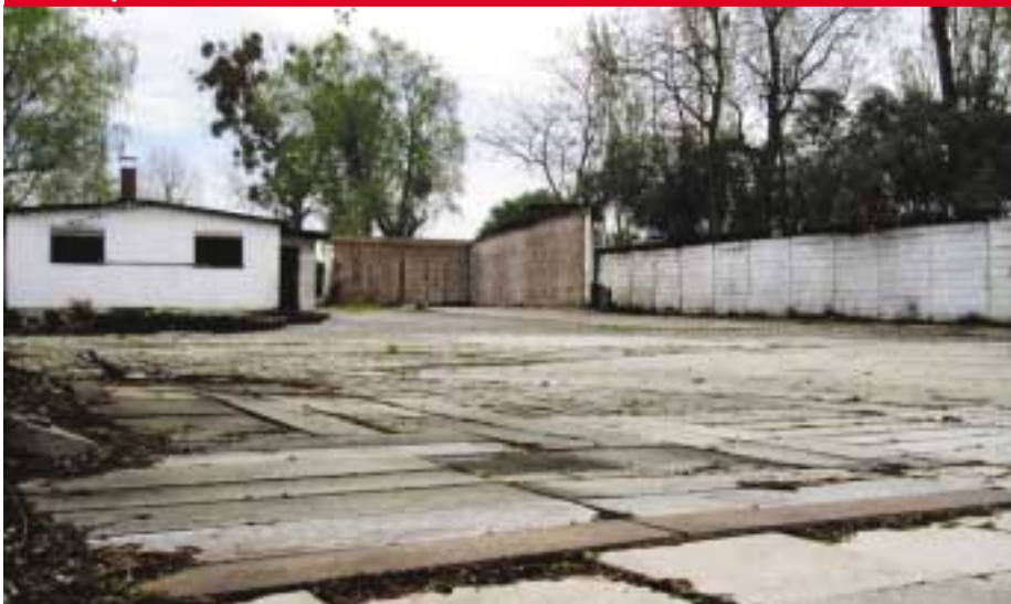
Links das vom Abriss bedrohte Gebäude der ehemaligen Kohlenhandlung in der Torgauer Straße
