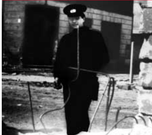
Volkspolizist an der eingerissenen Mauer
