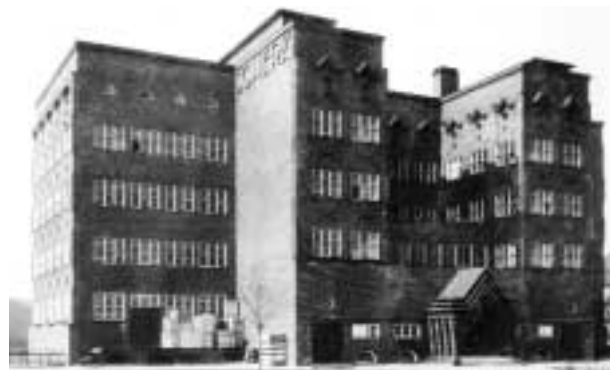
Firma Scherck in der Kelchstraße in Südende
