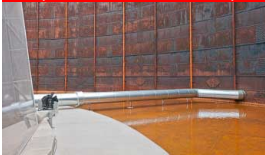
Der Gasometer - rostend und zusätzlich durch Ein- und Anbauten lädiert. Weitere Fotos in unserer Onlinegalerie. Foto: Hartmut Becker
